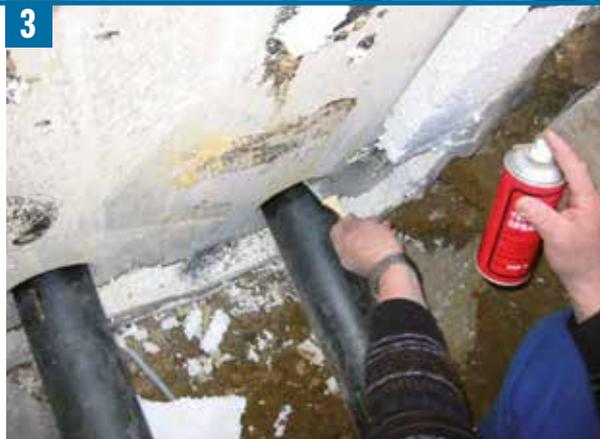
Anschließend wird der Ringspalt an der Außenseite der Wand mit einer PE-Rundschnur verschlossen und das Tangit Expansionsharz M 3000 durch die Fügestelle der PE-Rundschnur in den Ringspalt eingepresst (vgl. Bild 4).
