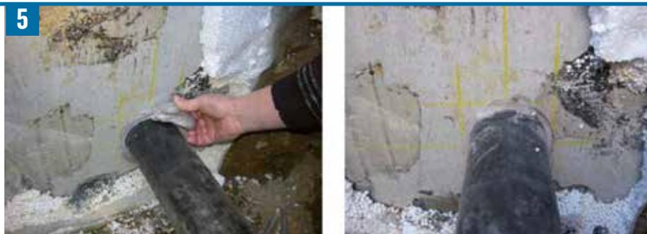
Im Kellerbereich werden die Rohre nun ebenfalls bis zum Dichtschlauch mit Teflon beschichtet, die PE-Rundschnur montiert und das Tangit Expansionsharz eingepresst (vgl. Bild 6).
