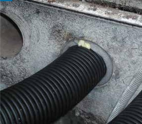
**6** Nach Aushärtung des Expansionsharzes kann überschüssiges Harz einfach mittels einer Säge entfernt und der Rohrgraben im Bereich der Einführung verfüllt werden.
