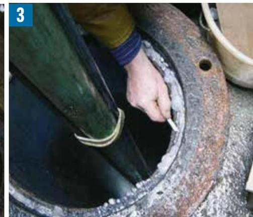
3 Ausgehärtetes Tangit M 3000 wird abgeschnitten
