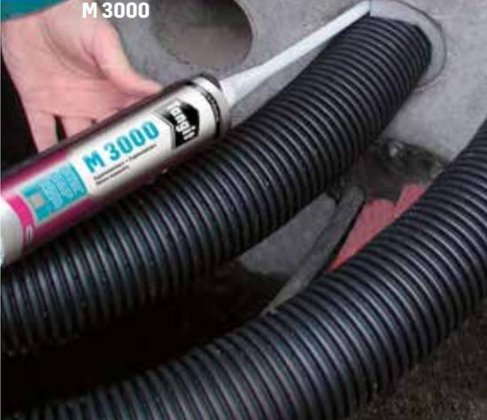
**5** Der Ringspalt zwischen Tangit Dichtschlauch M 4082 und PUR-Schnur wird mit Tangit Expansionsharz M 3000 verfüllt, um die Fixierung des Rohres im Mauerwerk zu gewährleisten. Er garantiert die vom DVGW in der VP601 geforderten Festigkeiten. Das Tangit Expansionsharz ist nach 5 Minuten endfest und nach 30 Minuten mechanisch voll belastbar.
