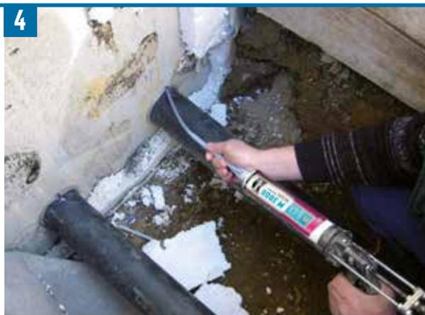
Nach abgeschlossener Expansion des Harzes (fünf Minuten) ist auch an der Fügestelle der PE-Rundschnur eine kleine Menge Harz ausgetreten. Der Ringspalt ist somit optimal gefüllt. Das ausreagierte Harz kann zusammen mit der Rundschnur entfernt werden (vgl. Bild 5). Die Montagearbeiten an der Gebäudeaußenseite sind damit abgeschlossen.
