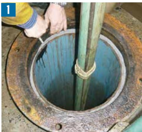
1 Einlegen des Tangit Dichtschlauchs
