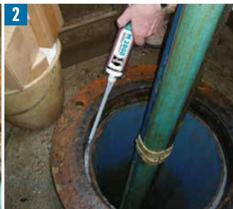
2 Einfüllen des Expansionsharzes in die Fuge
