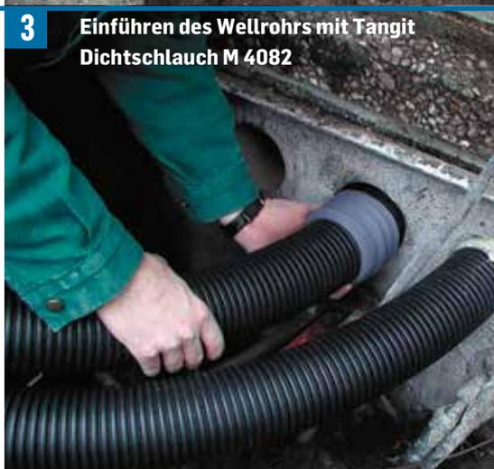
**4** Einführen des Wellrohrs mit Tangit Dichtschlauch M 4082
