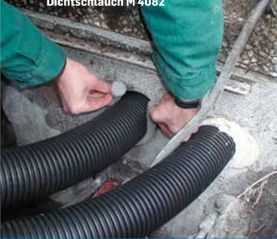
**4** Um ein Austreten des Tangit Expansionsharzes M 3000 zu vermeiden, ist es sinnvoll, eine Schalung am Ausgang des Ringspalts vorzusehen. Dazu dient die mitgelieferte Schalung oder alternativ eine flexible PUR-Schnur.
