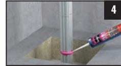
4 Tangit FP 450 um die Kabel herum und zwischen den Kabeln auftragen
