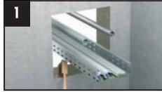
1 Leichtbauwand mit einer Dicke von = 10 cm: Schottdicke  $\geq 15$  cm
