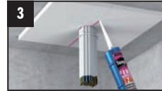
3 Fugen zwischen den Gipskartonplatten und um die Kabel herum mit Tangit FP 440 abdichten
