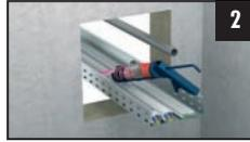
2 Tangit FP 450 um die Kabel herum und zwischen den Kabeln auftragen
